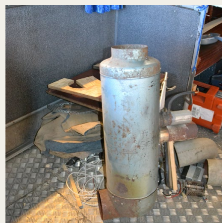
Den første portion ubrugelige indretninger og ledninger vi har fjernet fra bussen.
