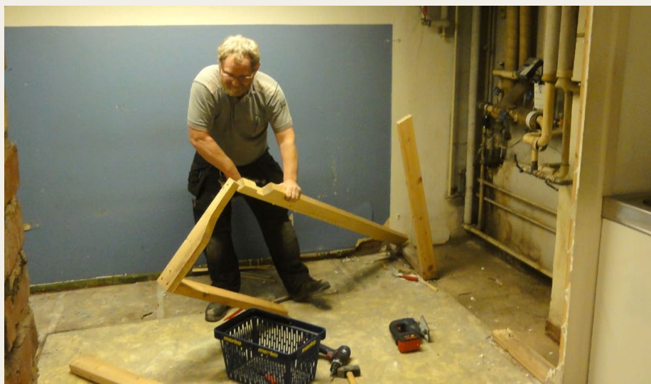
Peter Adamsen i fuld gang med at nedbryde væggen foran de tekniske installationer.
