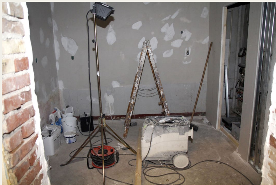
Dette billede er taget den 16. januar, og som man kan se, har der været en elektriker forbi, og de fleste vægge er beklædt med nye gipsplader.
