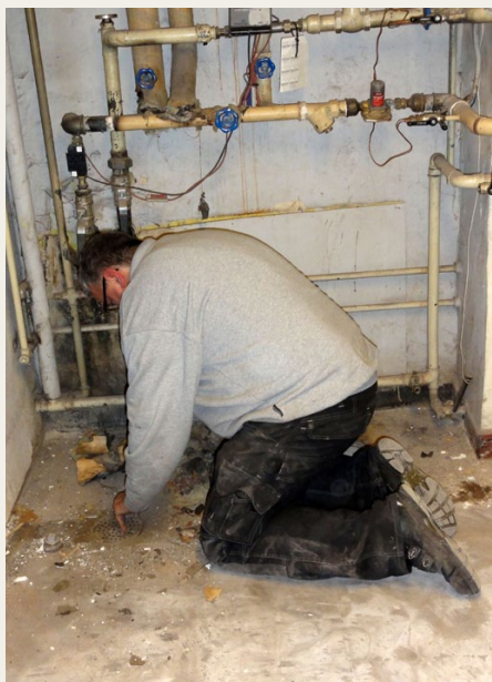
Steen Christensen er gået i gulvet for at kigge nærmere på det gamle afløb.
