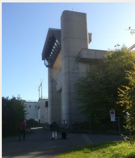
Indgang til Uelzen sluserne.
