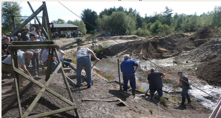
Manuel brunkulsgravning demonstreres. Hver mand i kæden kaster med skovlen kullene op til næste kasse.
