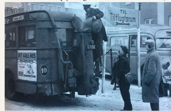
Fyring i gasgenerator bag på bussen en vinterdag under Anden Verdenskrig
