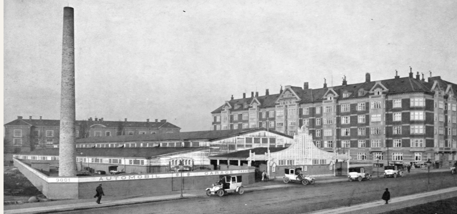
Den store garage i Stoltenbergsgade, København V, af arkitekt Knud Arne Petersen, taget i brug i 1910.
