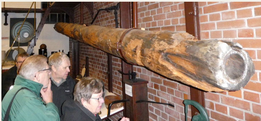
Vandteknisk Museum opbevarer et af de seks meter lange „trærør“, som allerede i 1836 blev anvendt til at bringe vand fra Blegkilde til Nytorv.
