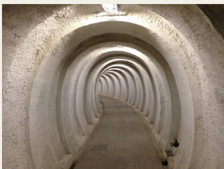
Indgangstunnellen. Det kurvede forløb og de bølgede vægge er for at mindske trykbølgen fra en eventuel atombombe.
