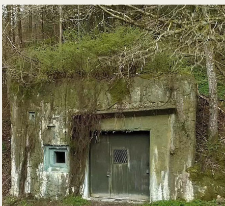
Den uanselige hovedindgang til bunkeranlægget.
