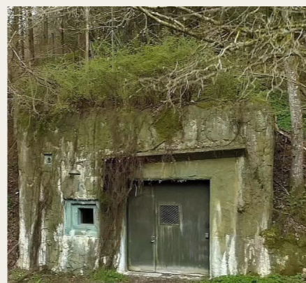
Den uanselige hovedindgang til bunkeranlægget.
