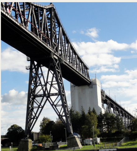
Den 67 meter høje jernbanebro over Kielerkanalen, som for tiden mangler sin svævefærg.
