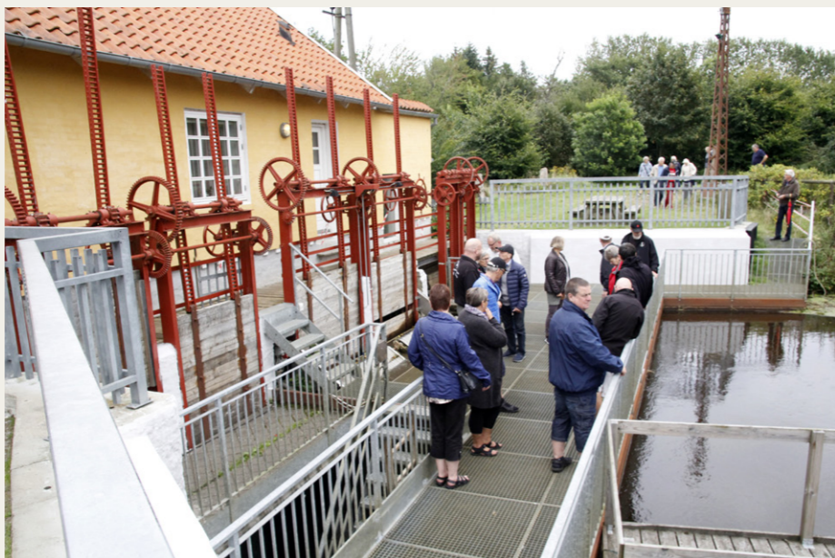
De to store sluser foran det gamle elværk regulerer vandstrømmen til de to turbiner, hvoraf kun den ene er i drift. Slusen længst væk er til at regulere overløbet.
