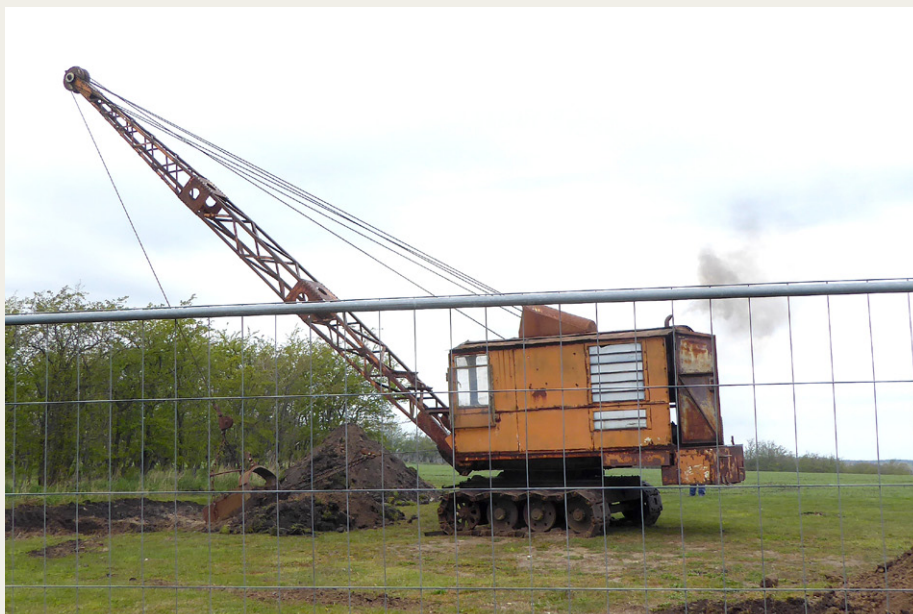
Den gamle PM1 gravemaskine fra Pedershaab Maskinfabrik AS i Brønderslev gravede store huller i marken bag motorsamlingen.
