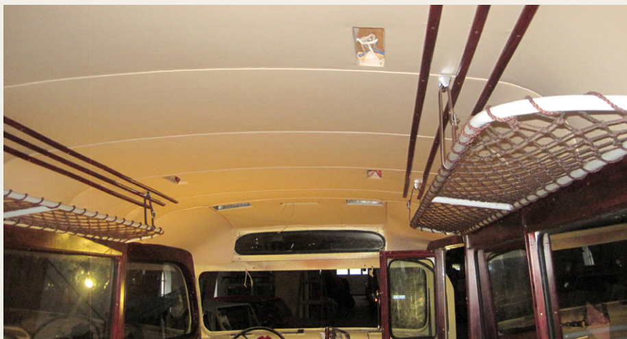
Indendørs er der monteret helt ny loftsbeklædning og fine bagagenet.
