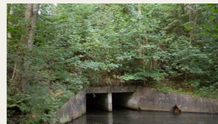
Indtil naturgenopretningsprojektet blev gennemført i 2013 og 2014 løb Gudenåens vand gennem de to rør under den skovklædte dæmning, som skjulte det, der engang var Nordens højeste stål-gitterbro.
