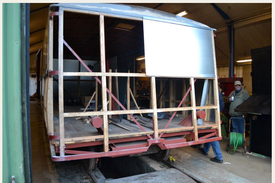
„Rumpeged“ under genopbygning med nyt træskelet og pladebeklædning.
