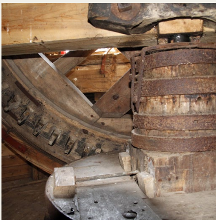
Her er en del af udvekslingen, hvor vingernes bevægelse overføres til den lodrette aksel ned igennem møllen.
