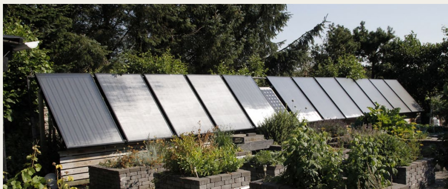
Energien til fordampning af havvandet kommer fra et utal af solfangere placeret rundt omkring på ejendommen.
