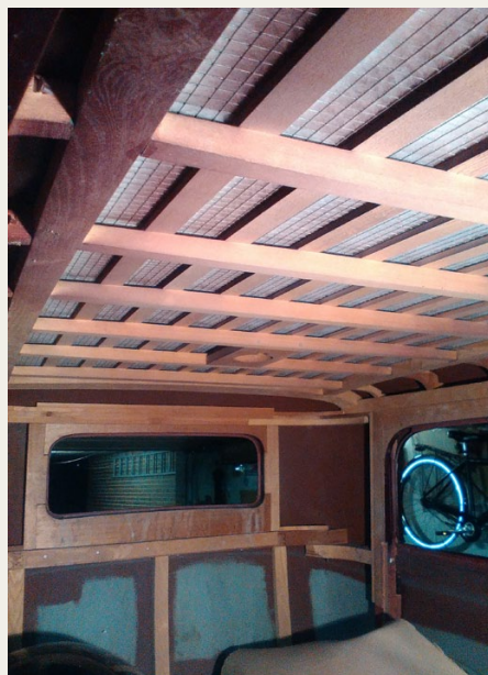
Der er masser af nyt træværk, men stadig en del arbejde, der skal laves.
